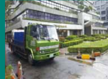
內湖廠 上車作業完成
